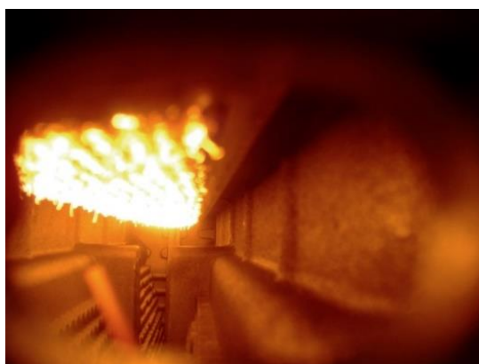
شکل ۲- مشعل تخت به کار گرفته شده در دیگ های چگالشی
